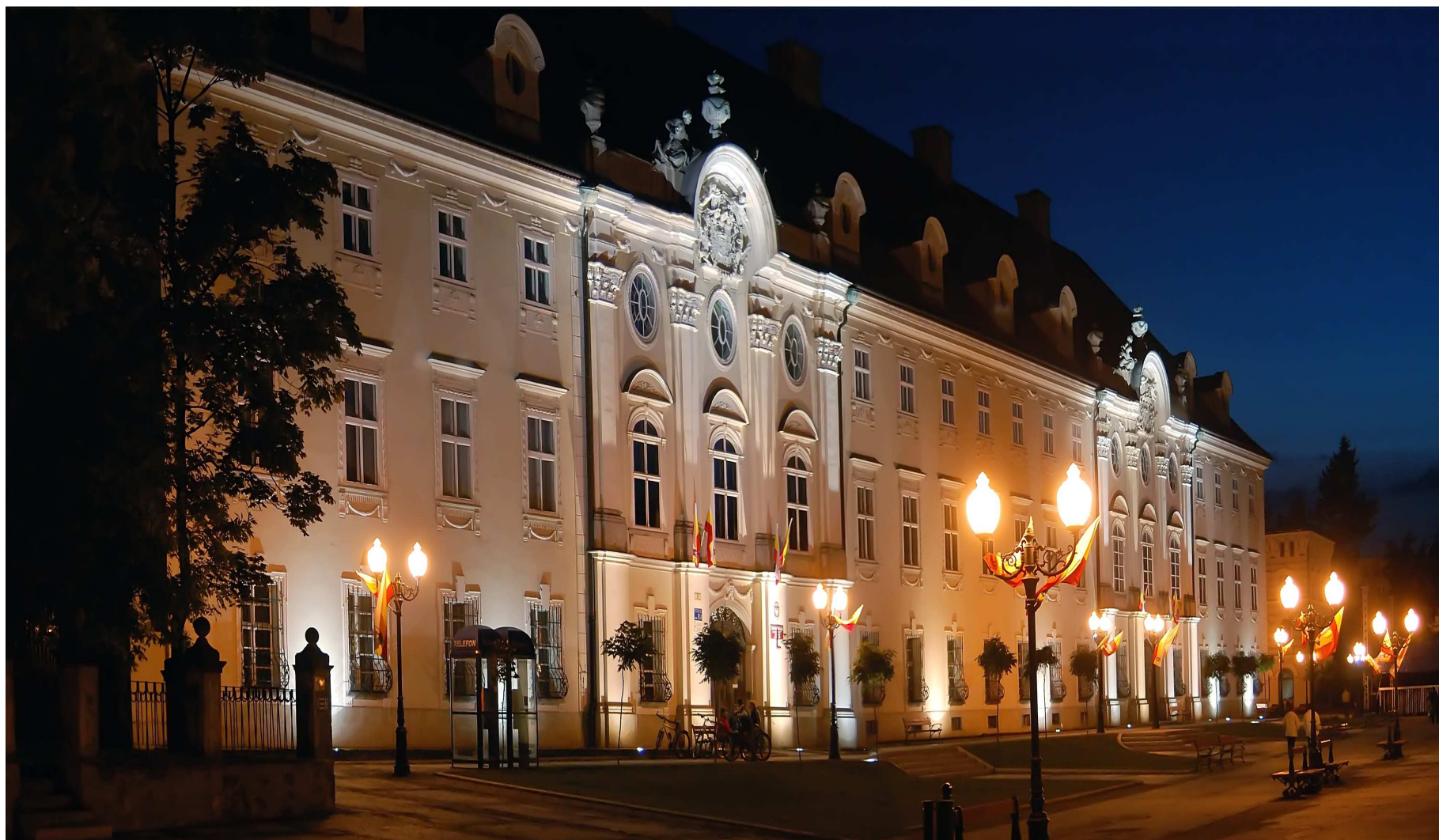
Pałac Schaffgotschów - studia elewów WOSR oraz początkowo studia techniczne Kolegium Karkonoskiego
